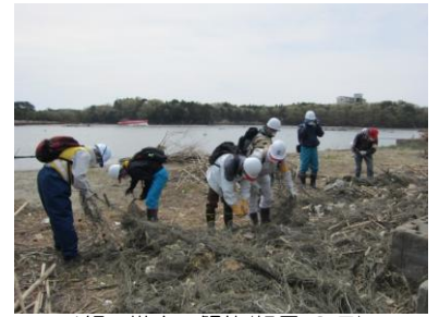
■フリ網の撤去・解体(相馬・3日)
